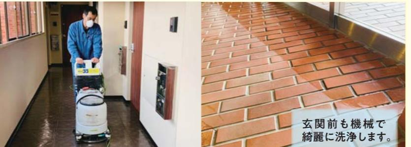
写真で使用している床面を自動で洗浄する機械の手元には、洗剤を撒くためのレバーがあります。適切な場所で洗剤を撒き、洗浄機の裏にあるパッドで汚れを落としながら進みます。その際に、隙間なく洗浄するため、洗浄し終えたところに少し被せながら機械を当てていきます。
