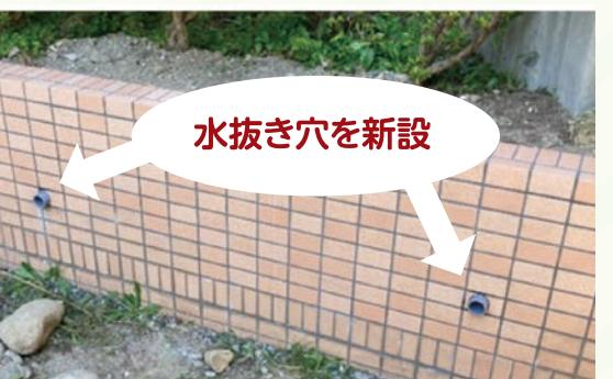
不良タイルや白華のひどいタイルを剥がして下地を補修した上で花壇内部の雨水が抜けるよう水抜き穴(花壇内部は目詰まりを防止するため、砂利を充填)を新設し、**白華の原因を解消したのちに新たにタイルの張替え**を行います。今後の白華現象を防ぐ対策の1つとして、ぜひ参考にしてみてください。
