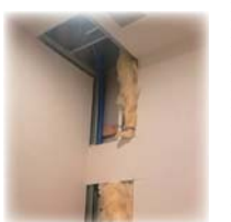
トイレの壁の様子→
