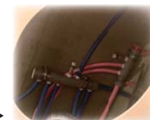
浴室天井の様子→
